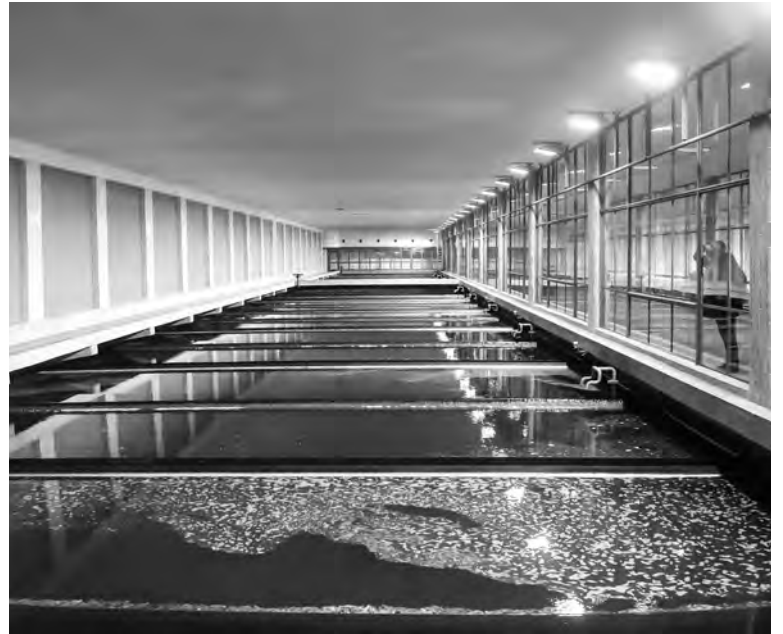
Frischwasserbecken im Wasserwerk Beelitzhof.
